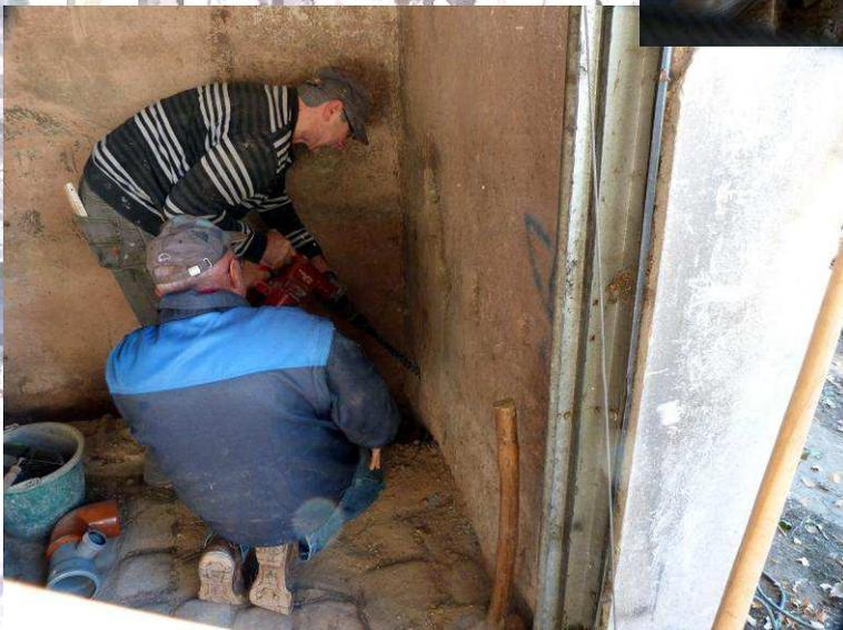
Hier entsteht der Durchbruch für den Abfluss
